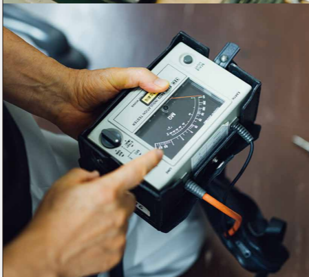
道具一つひとつを大事にするのも設備管理の仕事。下の写真は、劇場の道具の中でも最も古い機器で、漏電していないか電気回路を測定するもの
