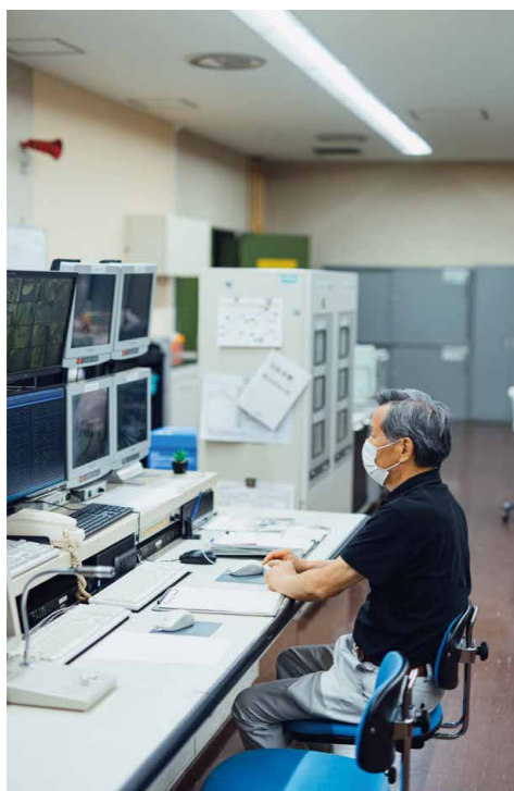
県立劇場内のすべての場所の温度と湿度を管理するモニター
