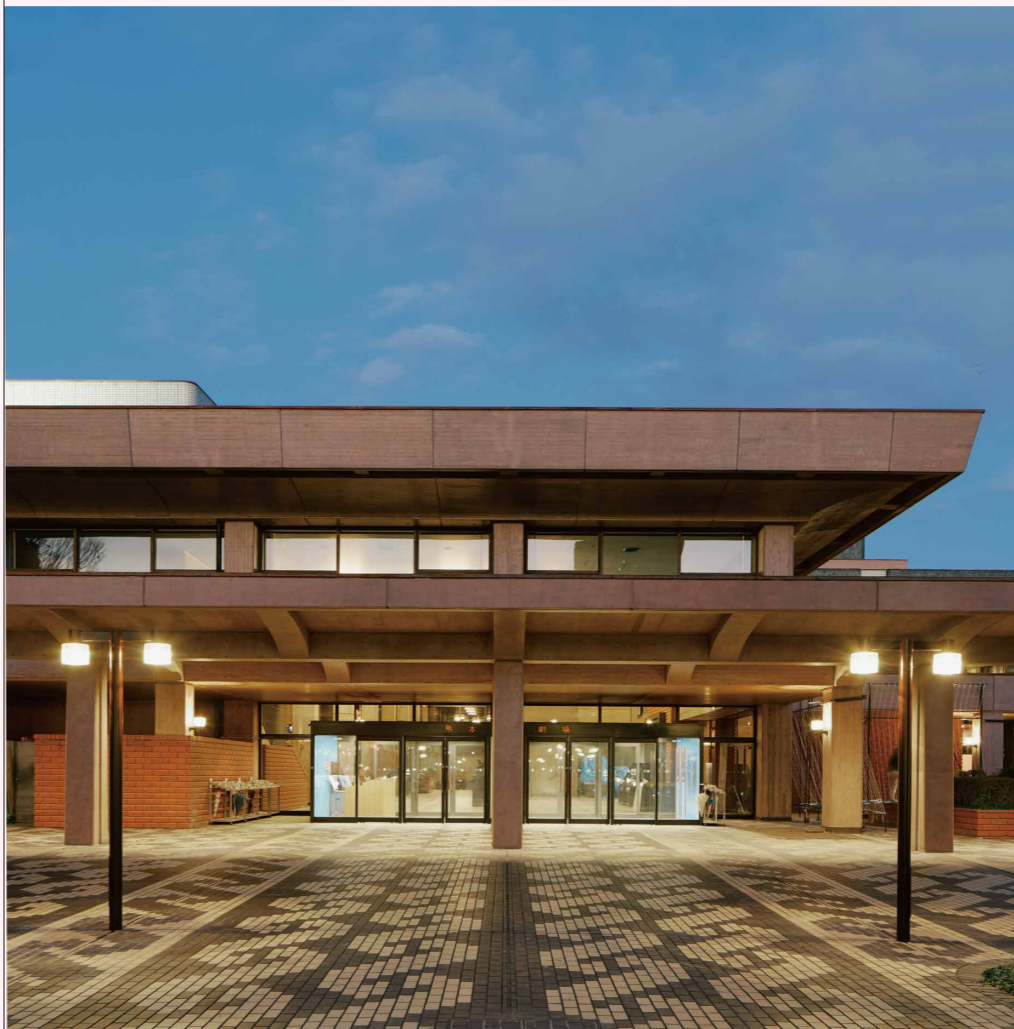
照明を整備することで、正面玄関の雰囲気が少し明るくなった
