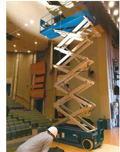
プロセニウム応急工事
