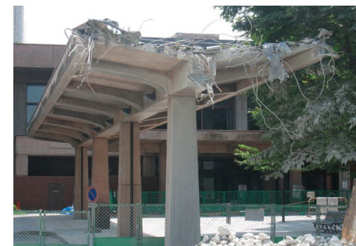
西側プロムナード車寄せ屋根損傷部撤去
