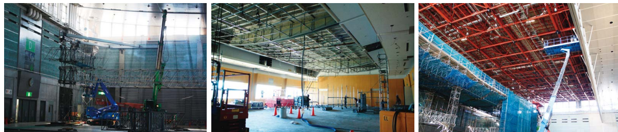
1階展示ホール補強工事で設置された「火打ち梁」 2階コンベンションホールの復旧工事
