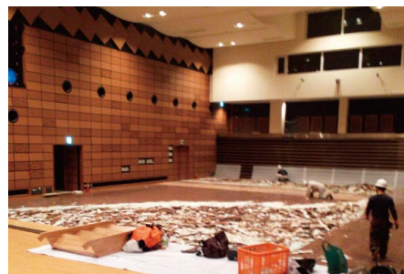
ホール床改修工事
