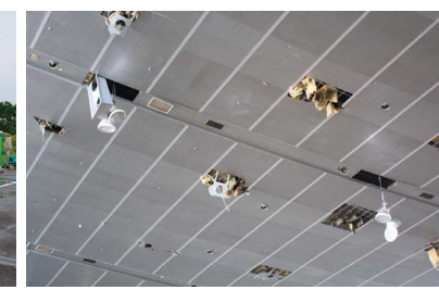
1階展示ホールの天井パネルや照明
