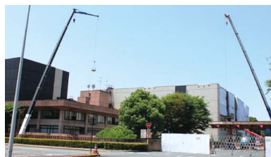
外壁の本格復旧工事
