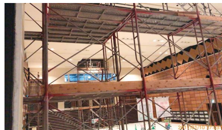
ホール天井改修工事
