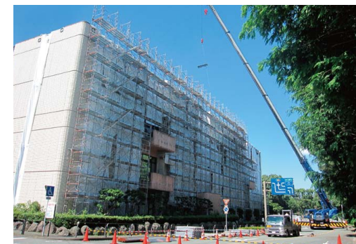
北側外壁PC板取外し
