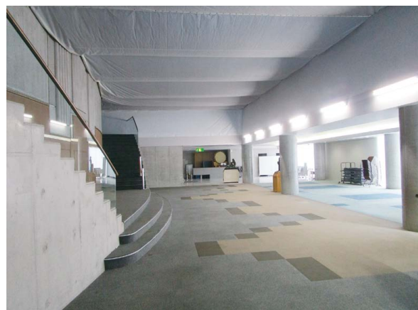
ロビー天井に二重ネット
