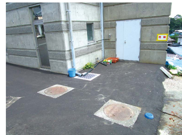
事務所付近段差調整
