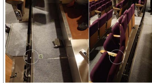
図③⑧ 引き出し席後部の中央部分:大きな隙間、歪んでしまった座席
