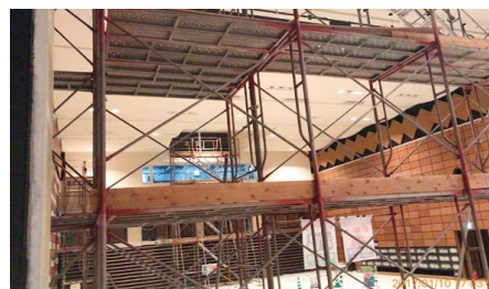
ホール天井改修工事
