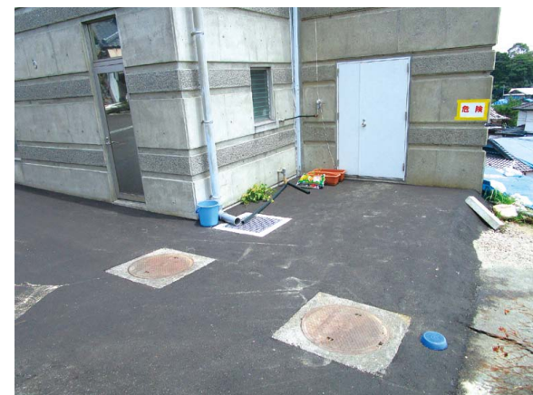
事務所付近段差調整
