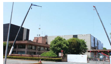
外壁の本格復旧工事
