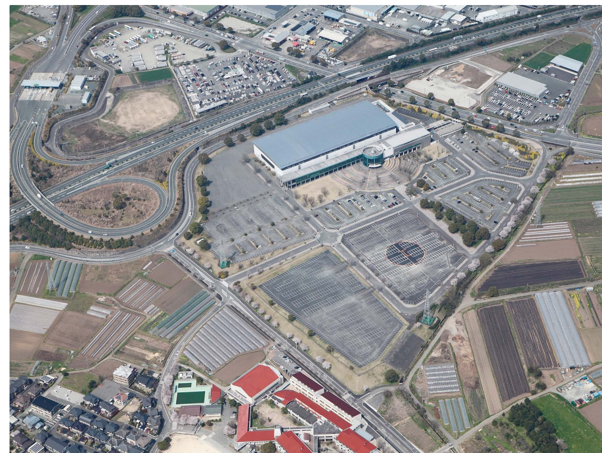
グランメッセ熊本全景(航空写真)
