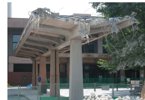
西側プロムナード車寄せ屋根損傷部撤去
