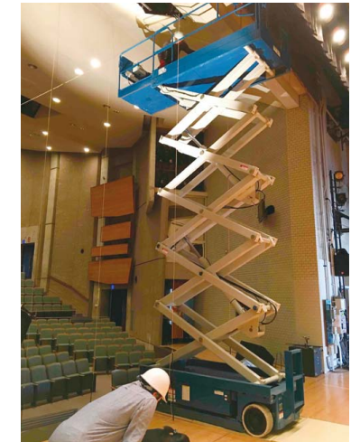
プロセニウム応急工事
