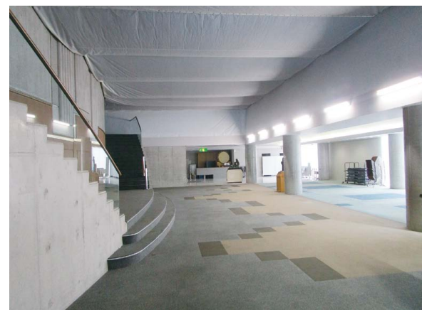
ロビー天井に二重ネット
