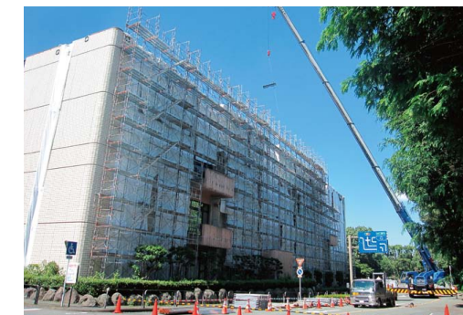
北側外壁PC板取外し
