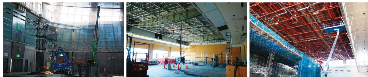
1階展示ホール補強工事で設置された「火打ち梁」 2階コンベンションホールの復旧工事 1階展示ホール天井部分の復旧工事
