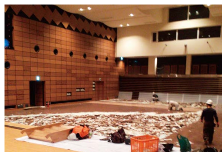
ホール床改修工事
