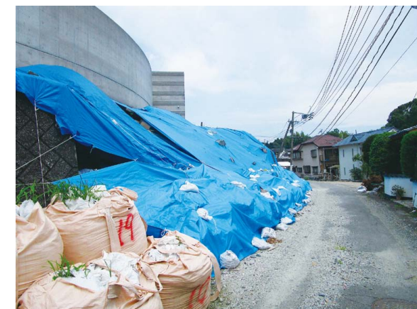
建物裏の倒壊した擁壁の上から養生
