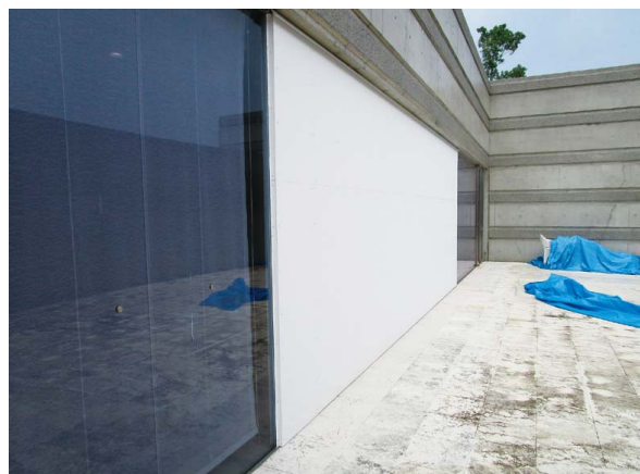
ロビー側テラスのガラス応急修理
