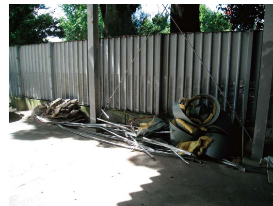
落下天井部材や空調吹出口などの瓦礫
